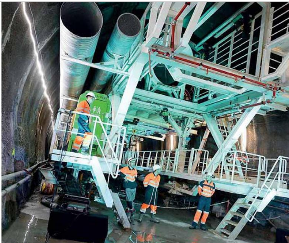
Un cantiere della Tav (Anca)
