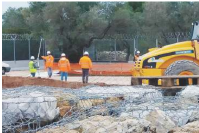
MELENDUGNO Il cantiere della Tap
